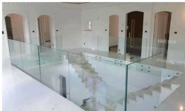
Chantier réalisé par la société EVMS
