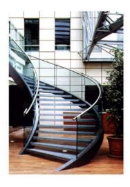
Ces verres sont obtenus à partir d'un verre plan qui est amené jusqu'à son point de ramollissement pour épouser la forme du support sur lequel il est placé.
